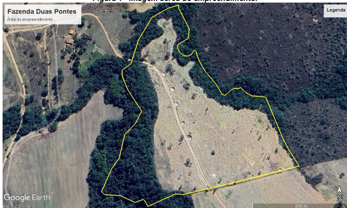
Figura 1– Imagem aérea do empreendimento.
