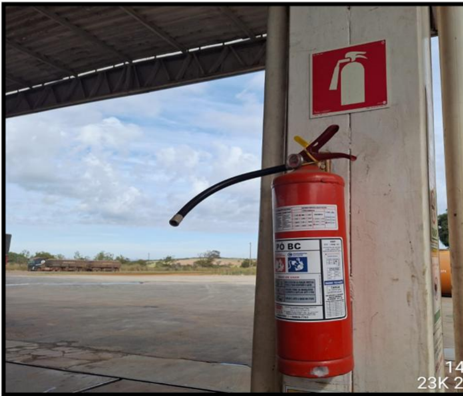
03 – Instalação de extintor de incêndio
