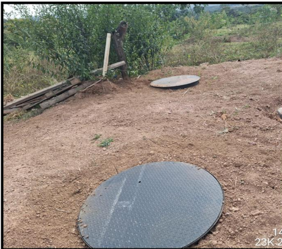
04 – Fossa séptica instalada
