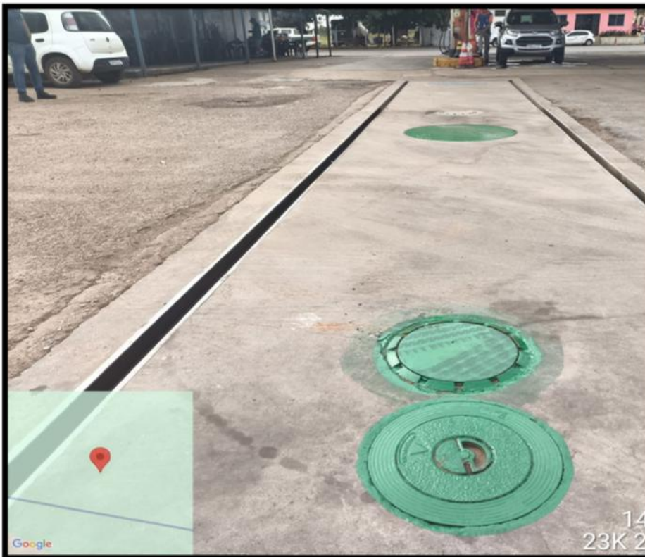
02 - Área de descarga e armazenamento de combustível
