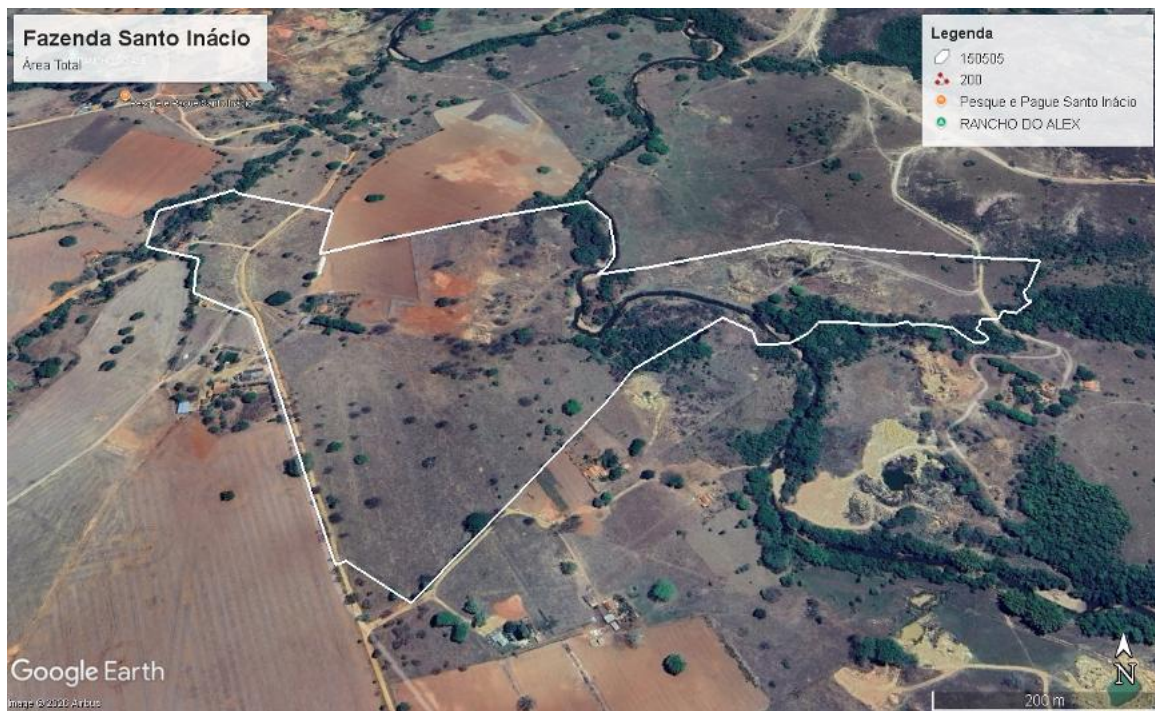
Figura 1– Imagem aérea do empreendimento.
