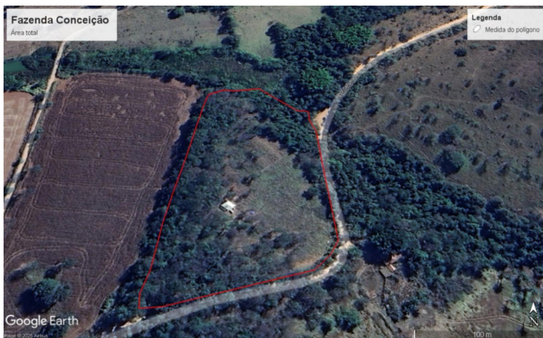
Figura 1– Imagem aérea do empreendimento.
