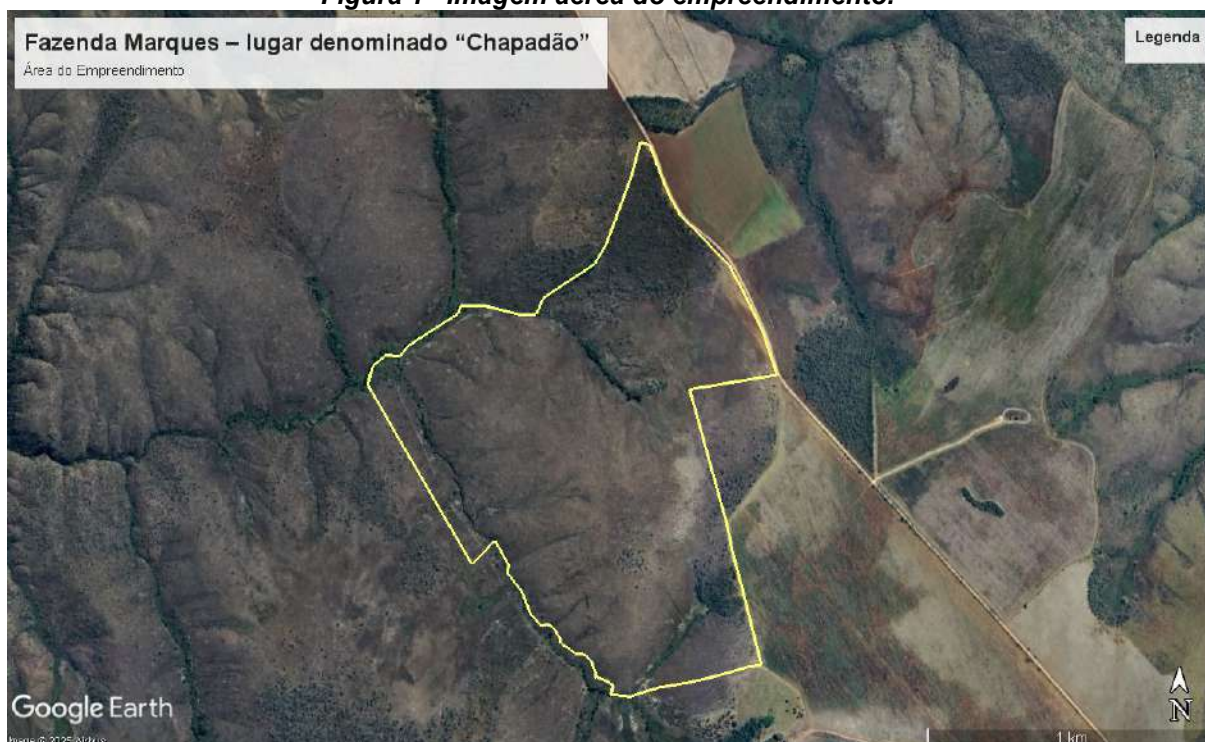
Figura 1– Imagem aérea do empreendimento.
