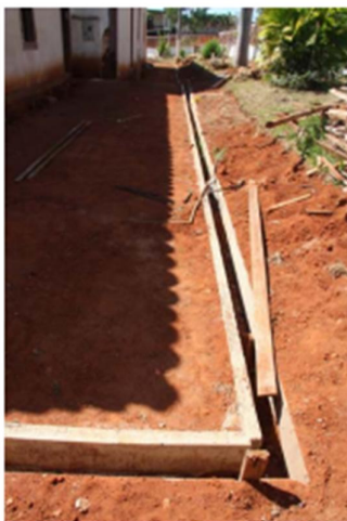
FIGURA 61 – Vista da canaleta em construção (FONTE.: Honório Nicholls Pereira, 26/10/2011).
