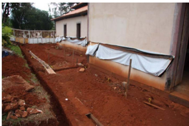
FIGURA 60 – Vista da valeta de drenagem aberta durante a obra da Matriz (FONTE.: Honório Nicholls Pereira, 02/05/2011).
