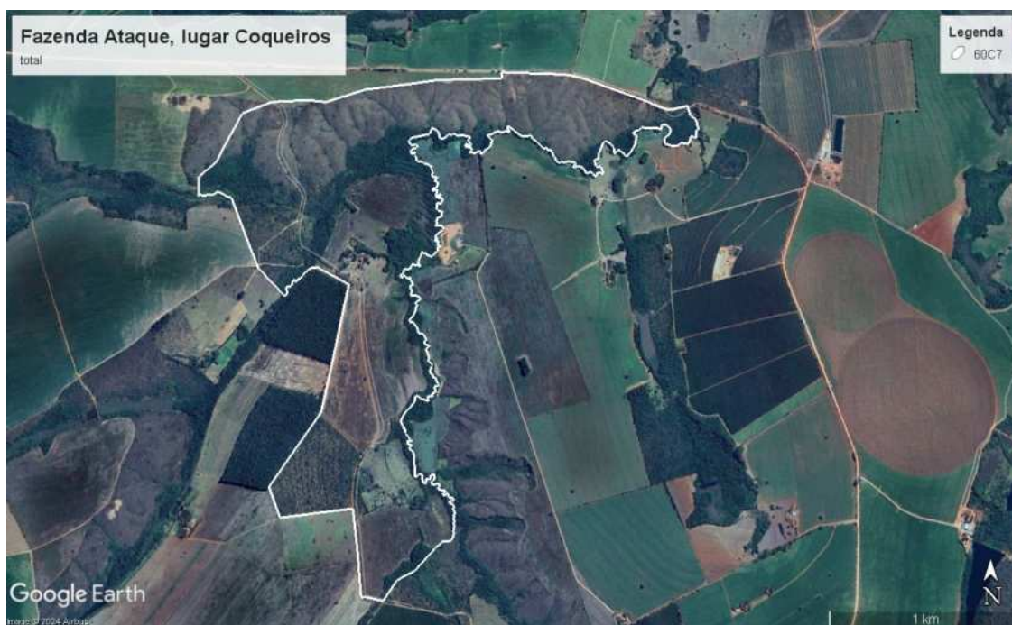
Figura 1– Imagem aérea do empreendimento.
