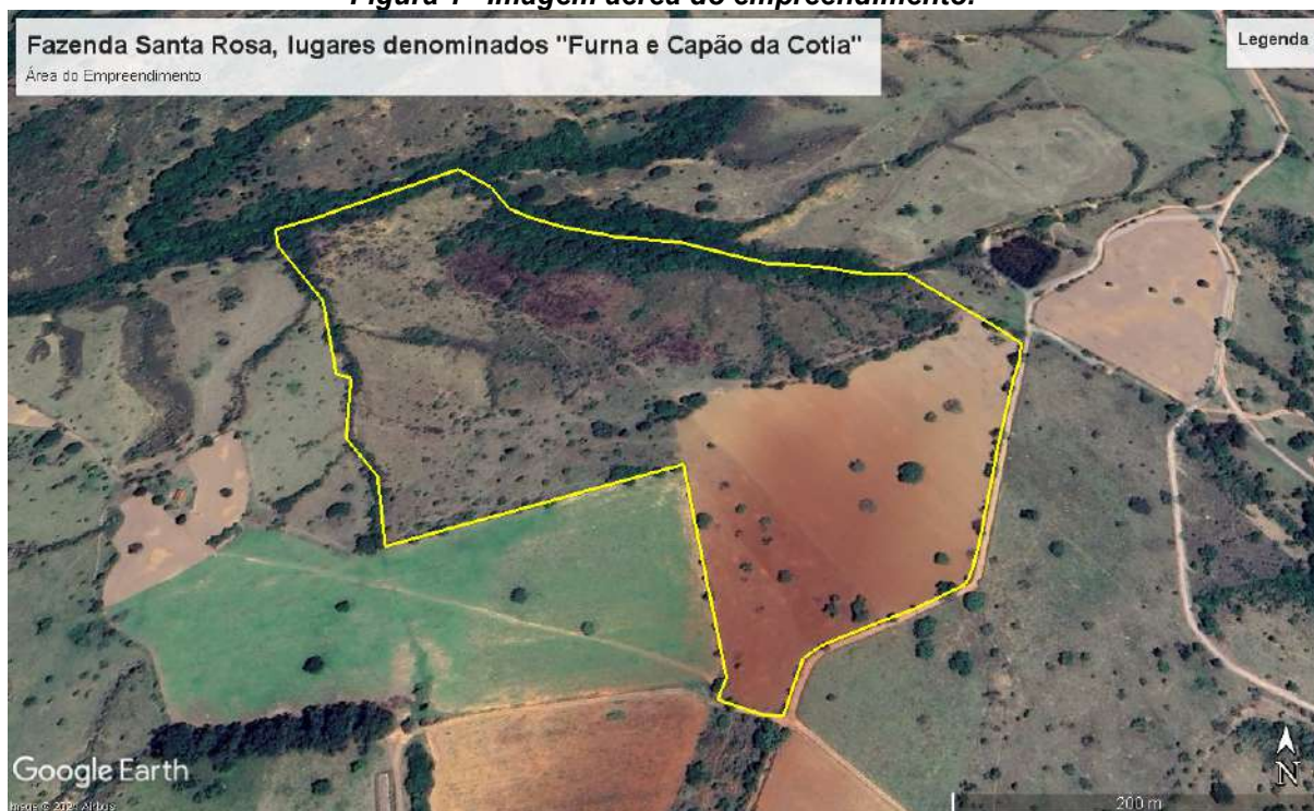
Figura 1– Imagem aérea do empreendimento.
