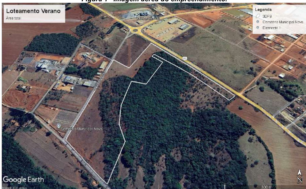
Figura 1– Imagem aérea do empreendimento.
