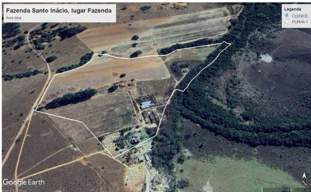
Figura 1 – Imagem aérea do empreendimento.
