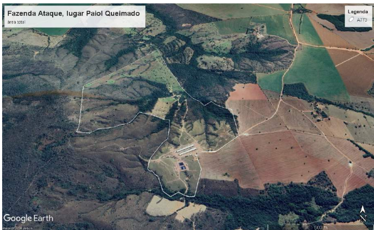
Figura 1 – Imagem aérea do empreendimento.
