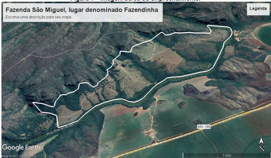
Figura 1 – Imagem aérea do empreendimento.
